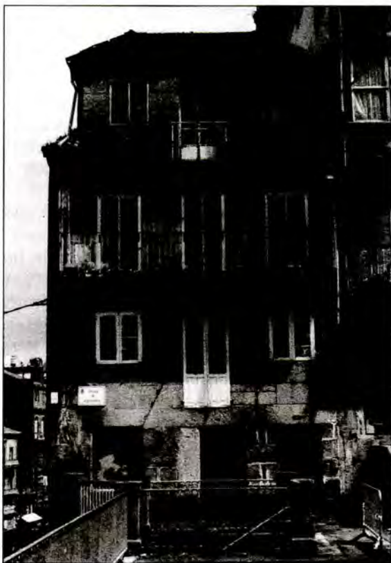
Nº10.-Estado actual. Alzado a Plaza de Argüelles. (Foto del autor).
