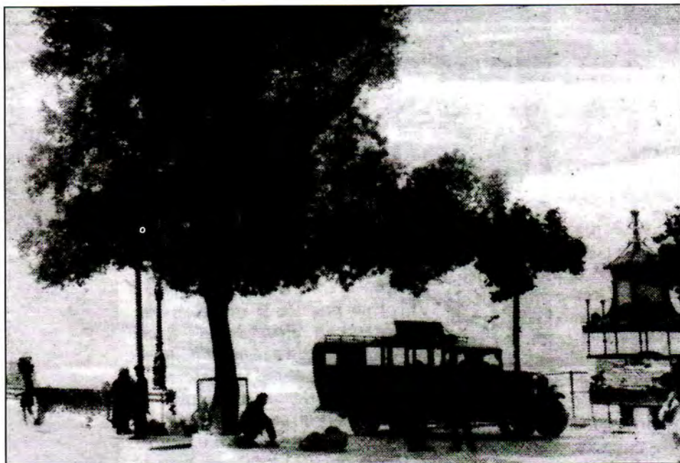
¿1930? Tres nuevos elementos alrededor del olivo: se reproduce parte de la nueva acera volada, el coche de línea para Baiona en su lugar de parada y el curioso urinario para caballeros (obra realizada por los talleres Sanjurjo de Vigo, ya desaparecido).
