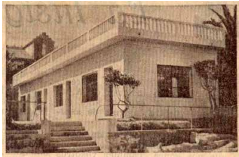
Fotografía de una de las edificaciones del colegio.
