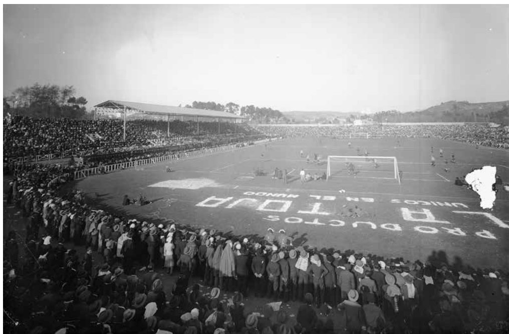
Figura 12. Vista do estadio desde o fondo oeste. Fonte: Arquivo Pacheco – Concello de Vigo
