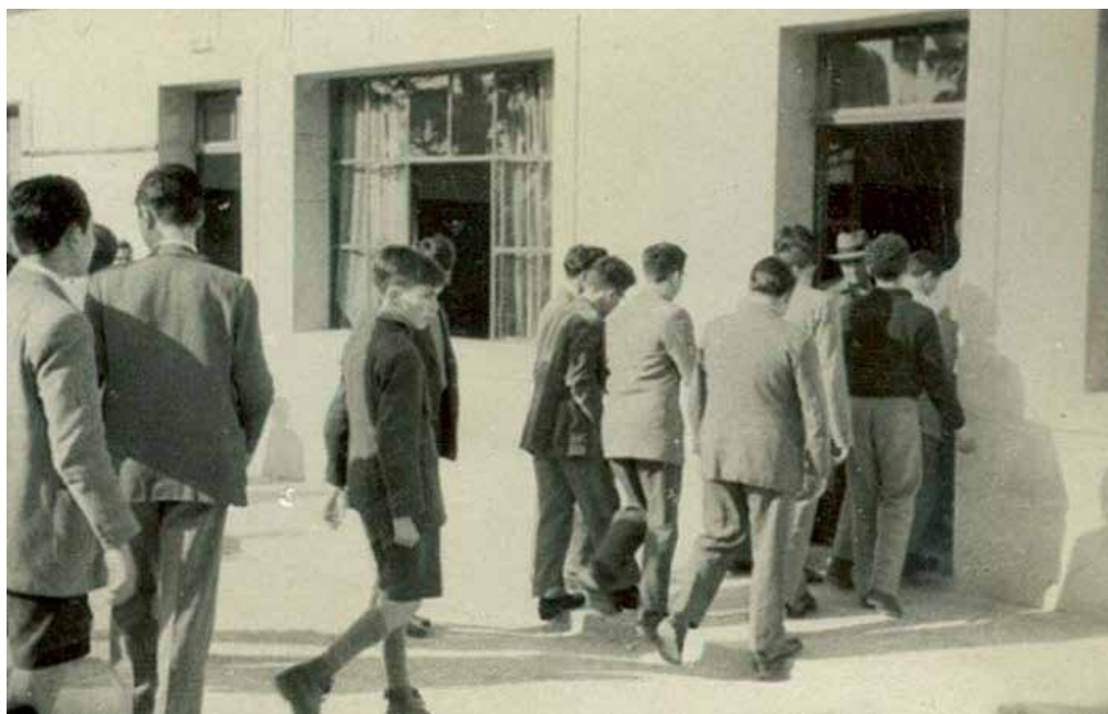
Fotografía de las entradas al colegio.
