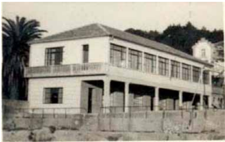
Fotografía de la nueva planta
