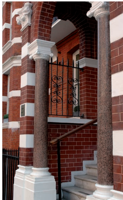
Pórticos de acceso aos bloques de vivendas Nevern Mansions (1890) da Nevern Square ( Earls Court ). Londres.
