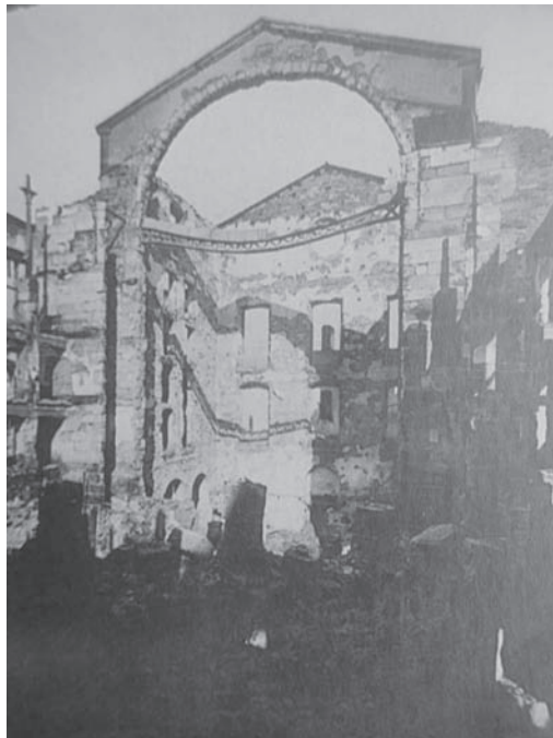
fig. 13. El interior del Teatro Cervantes o Rosalía tras el incendio que lo destruyó.
