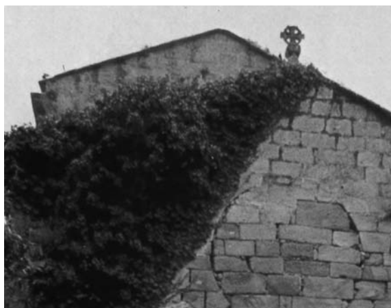
Figuras 17, 18 y 19. Las imágenes de la transformación de la cabecera nos permiten entender la intervención llevada a cabo, de arriba abajo, estado previo, durante y después de la intervención.
