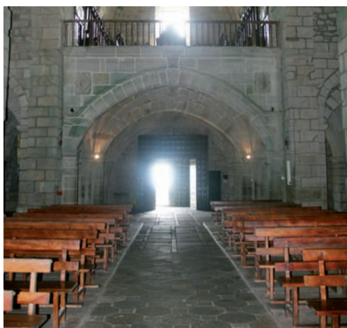
Figura 15,16. Comparando la imagen del estado previo a la intervención (arriba) y su resultado posterior (abajo) podemos apreciar algunos de los cambios producidos como el desplazamiento del pulpito, la eliminación del coro bajo, la transformación del coro alto, la eliminación del órgano o la eliminación del encalado interior que fueron con la transformación de la cabecera, las intervenciones más importantes sobre el conjunto en el el siglo XX.
