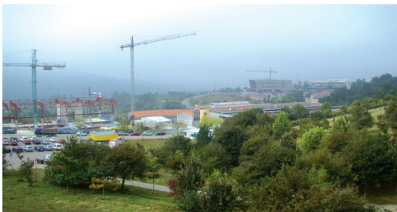
Figura 4: Obras na Universidade de Vigo.
