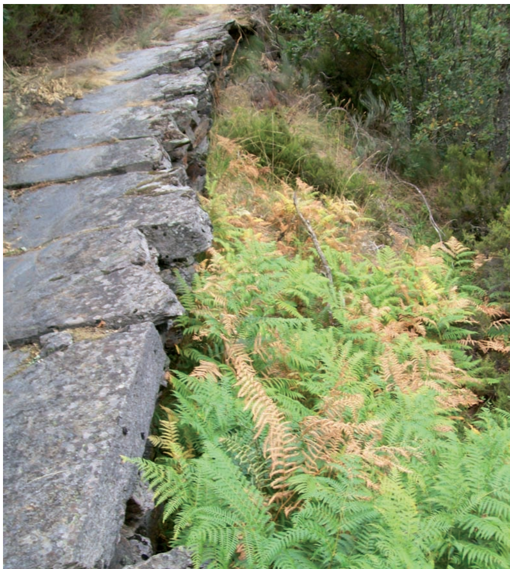
Calzada cicloópea de Pradoalbar a Cerveira. Debaixo, tapado polos fentos está unha muralla de asento de varios metros de altura.
