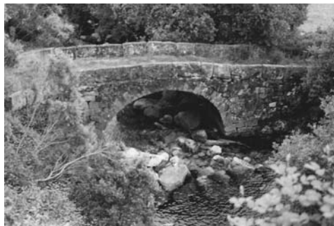
Ponte sobre o Cervés (Melón), 1981. Os escombros veñen das obras dos 70.
