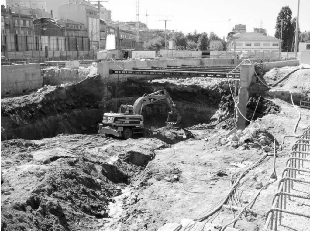
Fig. 2. Vista obras en P.K. 0+800.
