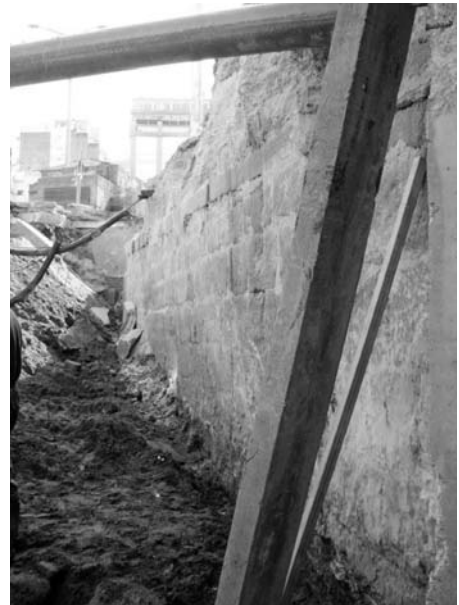
Fig. 5. Vista en perfil de uno de los lienzos del muelle durante la excavación del túnel, Pk 0+880.
