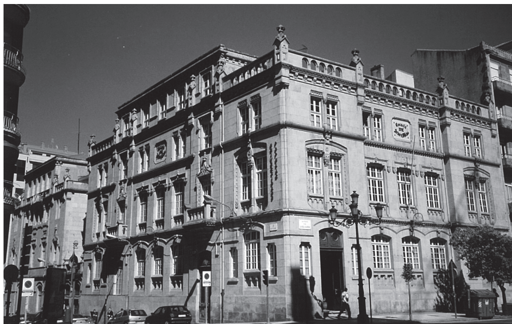
Edificios de las Escuelas de Artes y Oficios, y de Artes e Industrias de Vigo, obra del arquitecto francés Michel Pacewicz. El Anejo es el de la izquierda.
