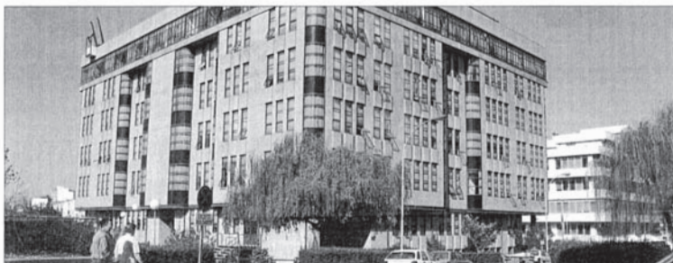
La construcción del nuevo edificio permitirá desahogar las dependencias del actual Palacio de Justicia.
