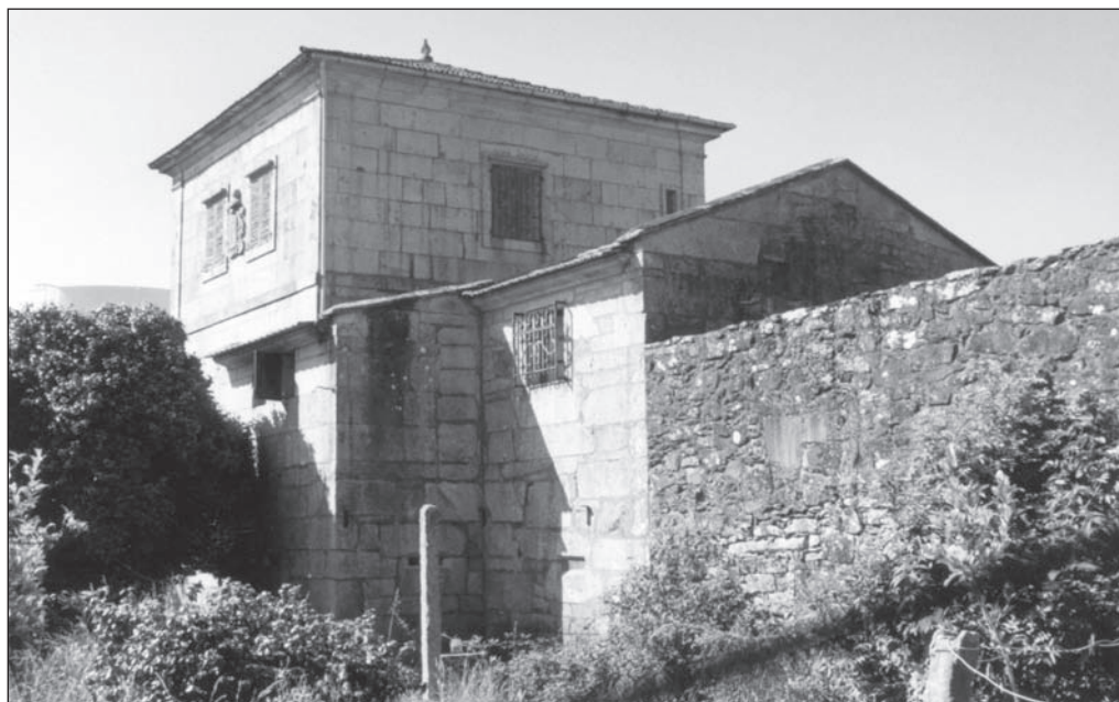
Pazo de A Raposeira. Detalle de la fachada Sur.
