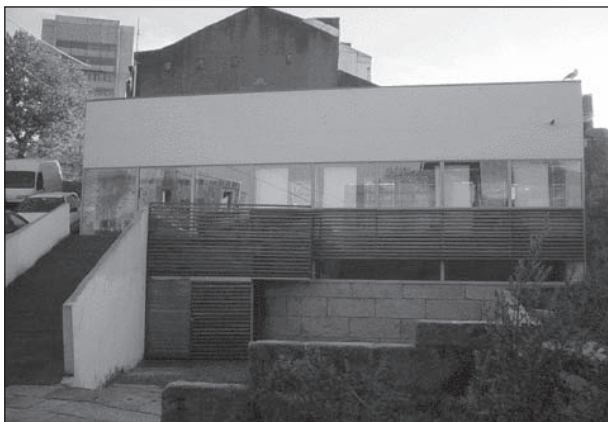
Edificio do CAT situado na Rúa Subida ao Castelo, nº 10.
