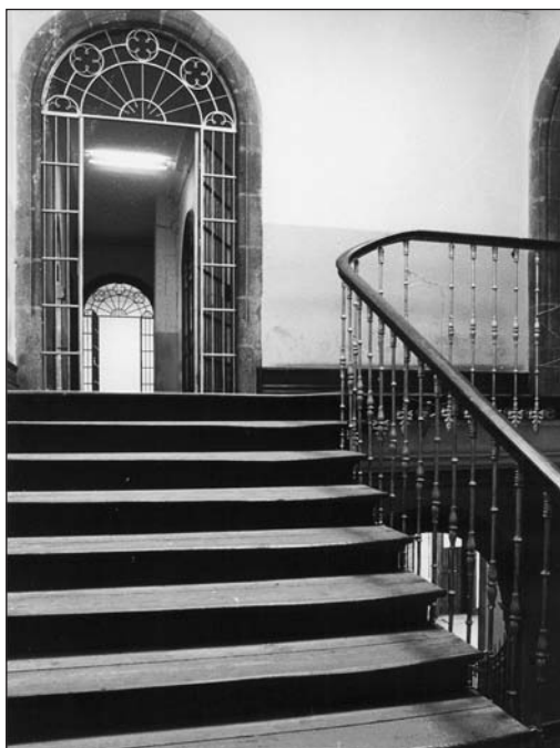
Antiguo Palacio de Justicia. Acceso a la primera planta antes de su remodelación (foto Vicente)
