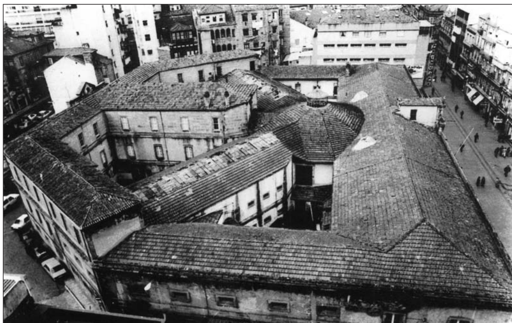
El conjunto edificado del antiguo Palacio de Justicia antes de su remodelación
