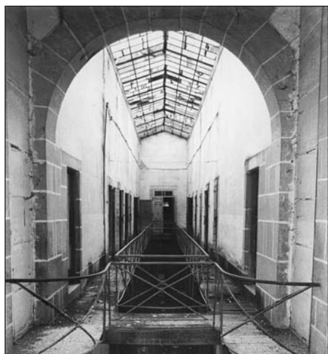
Galería de prisiones vista desde la primera planta
