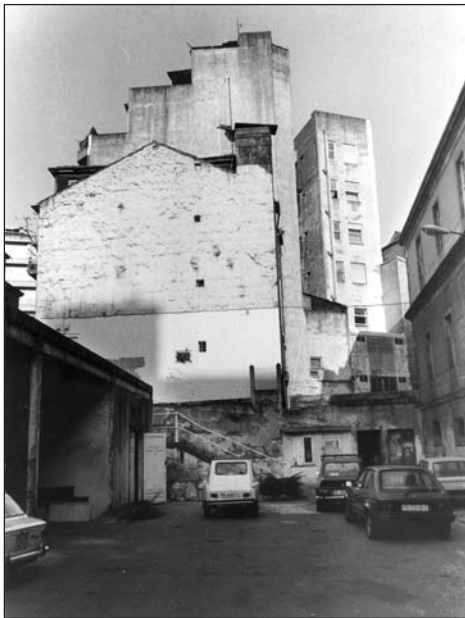
Inaudita vista de la parte sur de la fachada posterior con aparcamiento de coches, galpones, medianerías vistas, etc.
