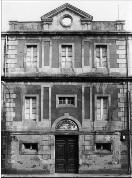
Fachada posterior del antiguo Palacio de Justicia antes de su remodelación, donde se ubicaba el Archivo Municipal hasta su traslado al nuevo edificio
