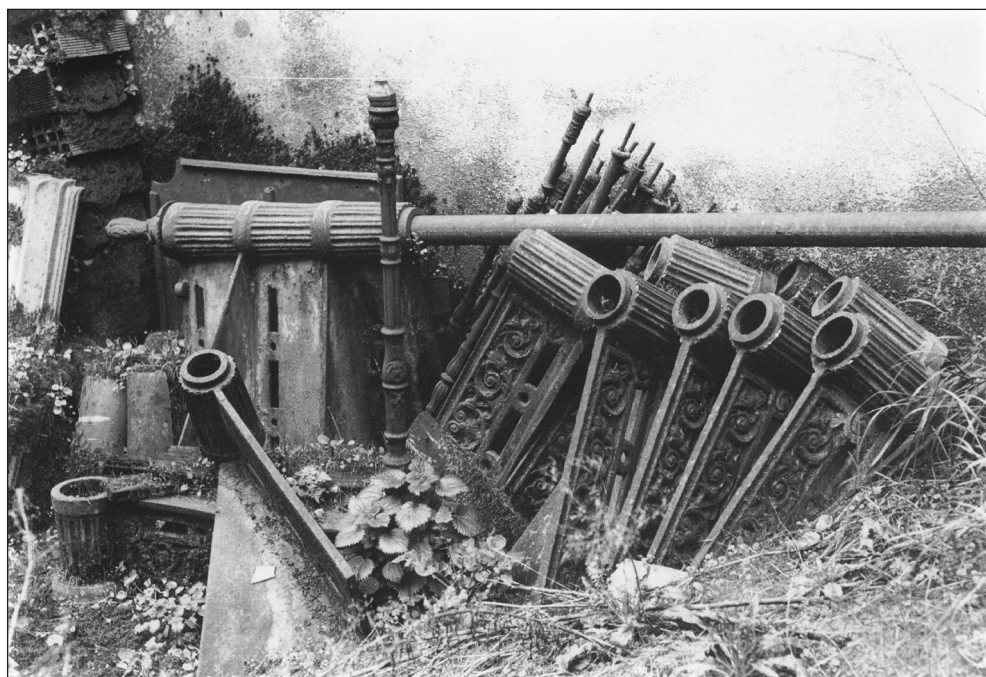
Hierros caídos de una de las dos escaleras de hierro fundido existentes
