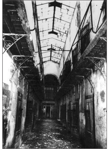
Interior de una de las dos alas radiales dedicadas a prisión con abundante iluminación cenital
